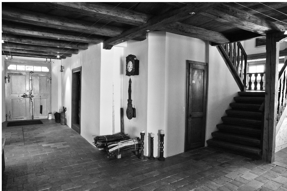
Hausgang mit den alten Tonplattenboden
