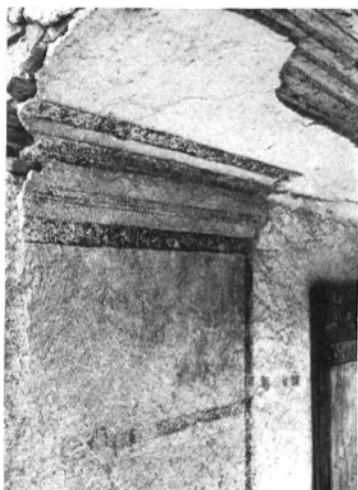
3 Mettmenstetten, Wohnhaus im «Buchstock». Ecklisenenmalerei (wohl von 1792/93) im Originalzustand.
