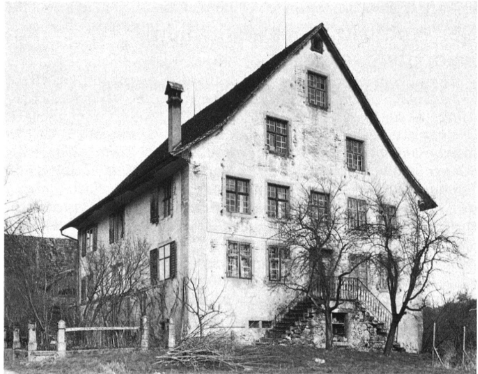
1 Mettmenstetten, Wohnhaus im «Buch- stock» vor der Restaurierung, Zustand 1983.
