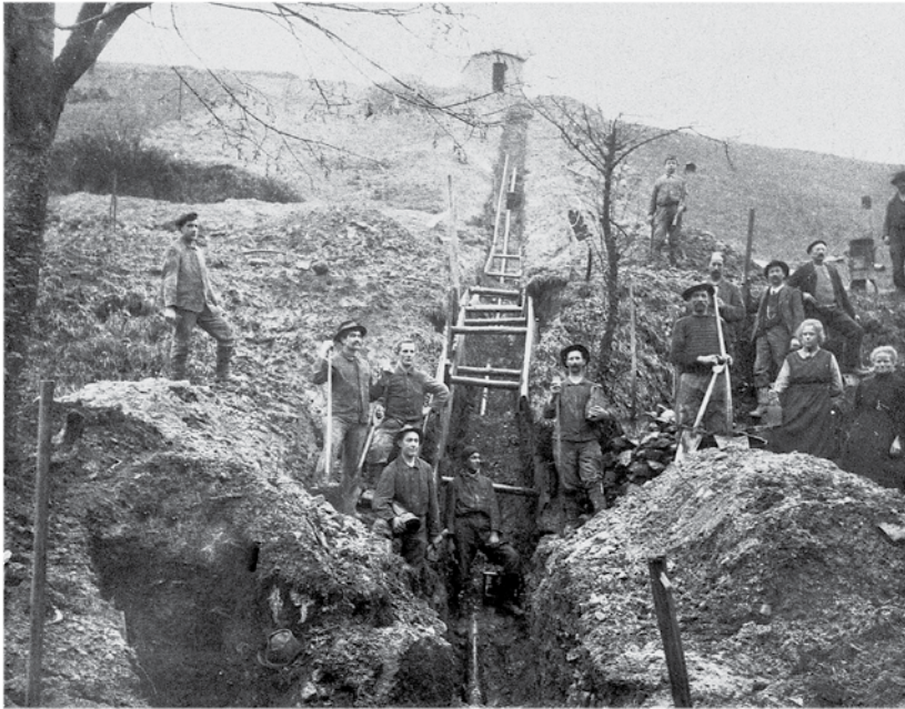
ca. 1920: Leitungsbau Gerensteg
